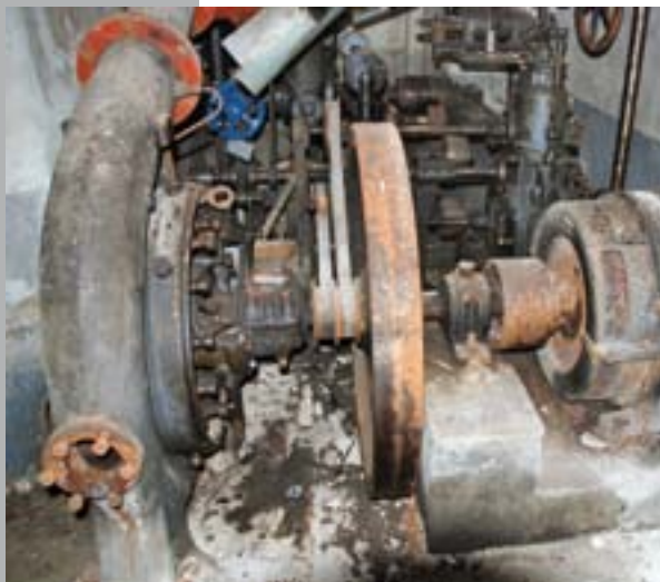
Francis-Turbine (links) mit Generator vor dem Ausbau im Turbinenraum
