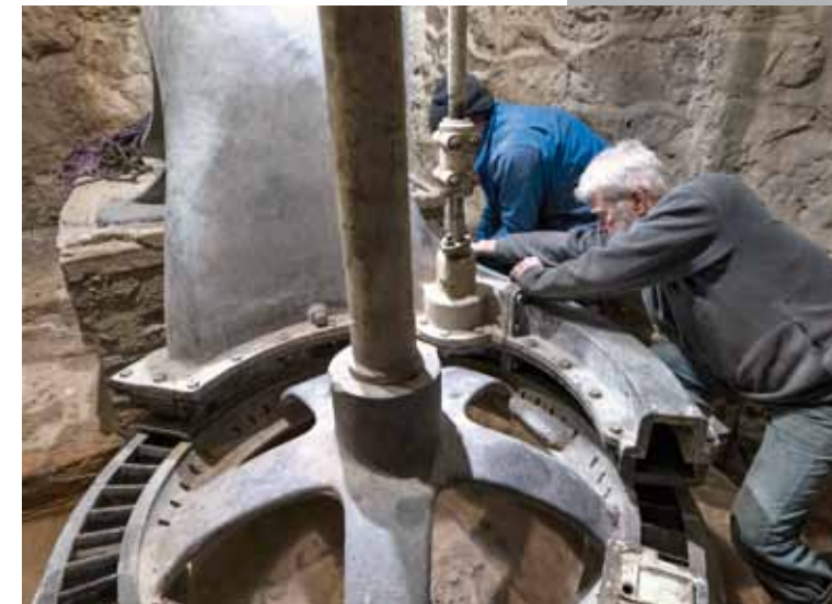
Spezialisten beim Wiedereinbau der Girardturbine nach der Reparatur
