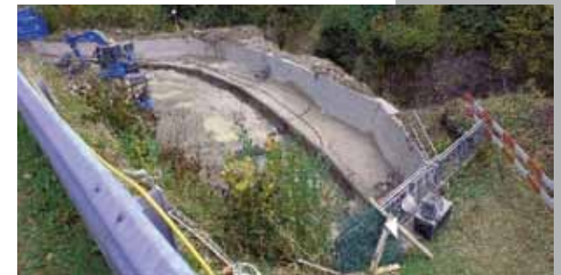
Die neue Stützmauer entsteht (Mitte, unten)
