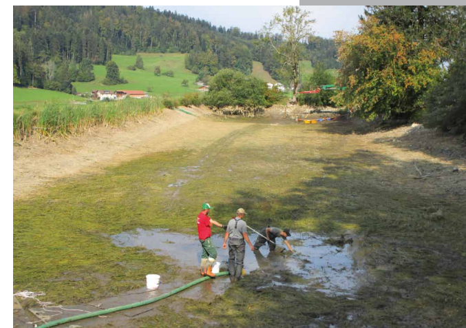
Sanierungsarbeiten am Grund des Farnböölweiher
