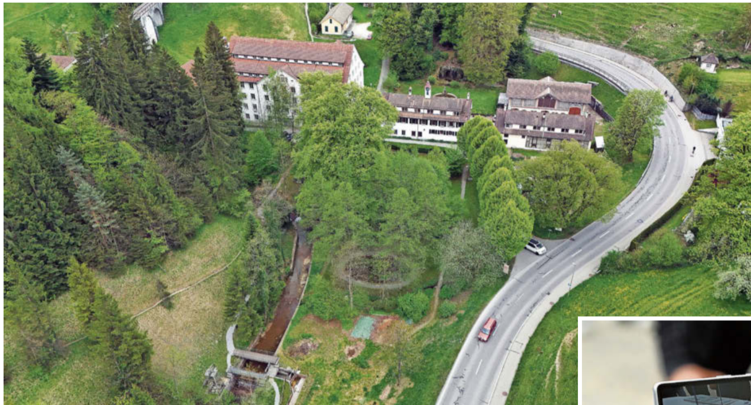
Auf dem Audio-Rundgang erkunden Besucherinnen und Besucher das Areal ausserhalb der Fabrik und lernen Neues über die Wasserkraft.
