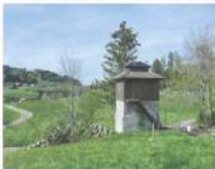
1879 wurden anstelle der Wasserräder drei Turbinenhäuser erstellt.
